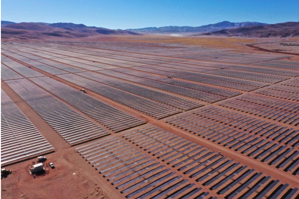
Figura 7. Parque solar Caucharí en la provincia de Jujuy [15].
