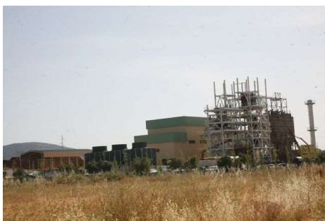
Figura 12. Planta de biomasa de la empresa Aldebarán situada en Andújar (Jaén)
