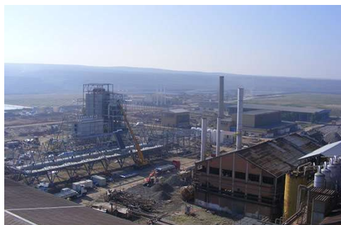
Figura 13. Planta de generación eléctrica con Biomasa en Linares.
