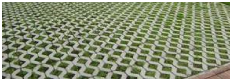
Figura 6. Pavimento de hormigón para exteriores.
