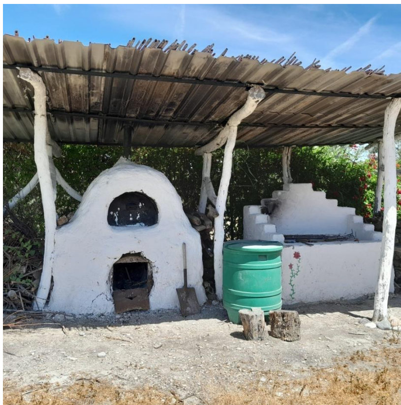
Imagen 19. Construcción horno de permacultura. Granja Caprinatura. El Donadío (Úbeda) Jaén. 2022.
