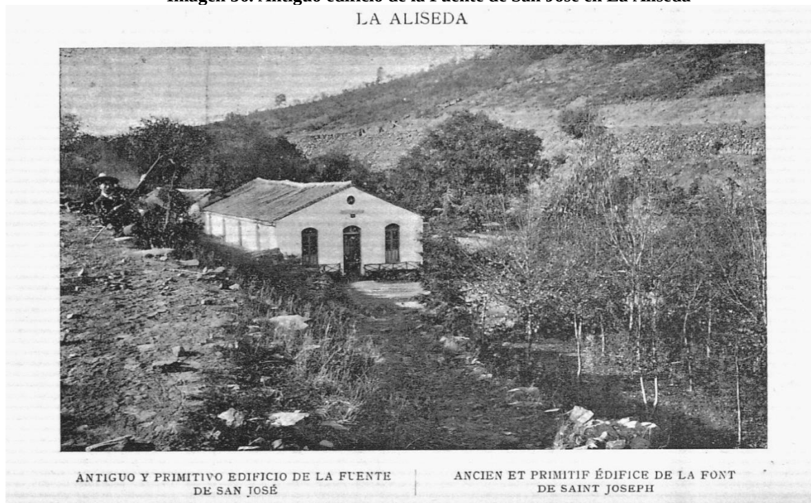
Imagen 56. Antiguo edificio de la Fuente de San José en La Aliseda
