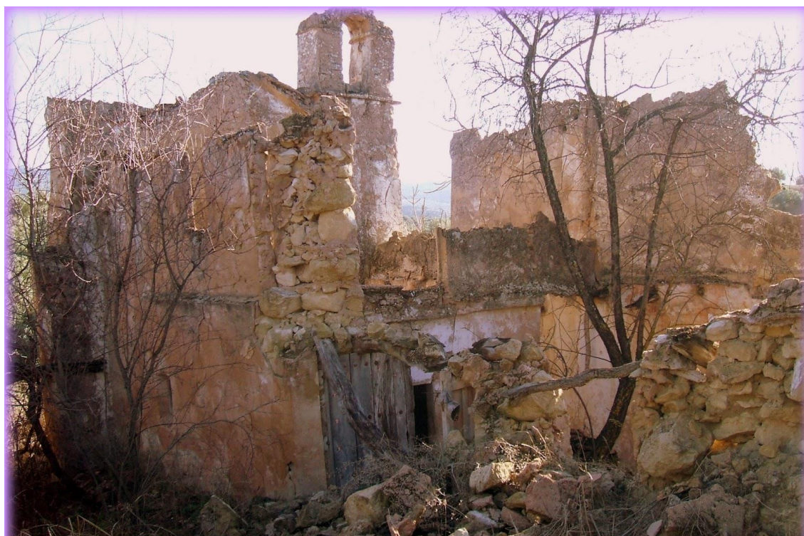
Imagen 77. Ruinas de la casa de pobres. Baños de Fuente Álamo
