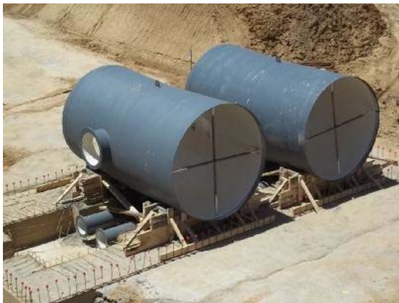
FOTOGRAFIA. - Comienzo de montaje de tubería de junta soldada, pieza metálica desagüe DN2600
