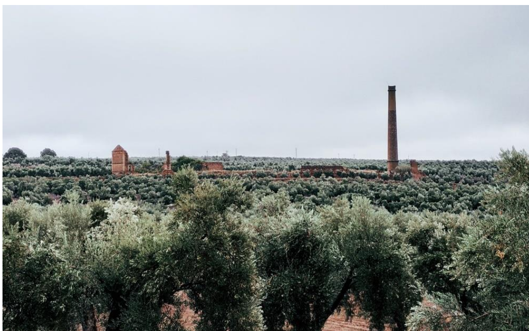
Figura 14. Estado actual de la fundición de San Luis (imagen original).
