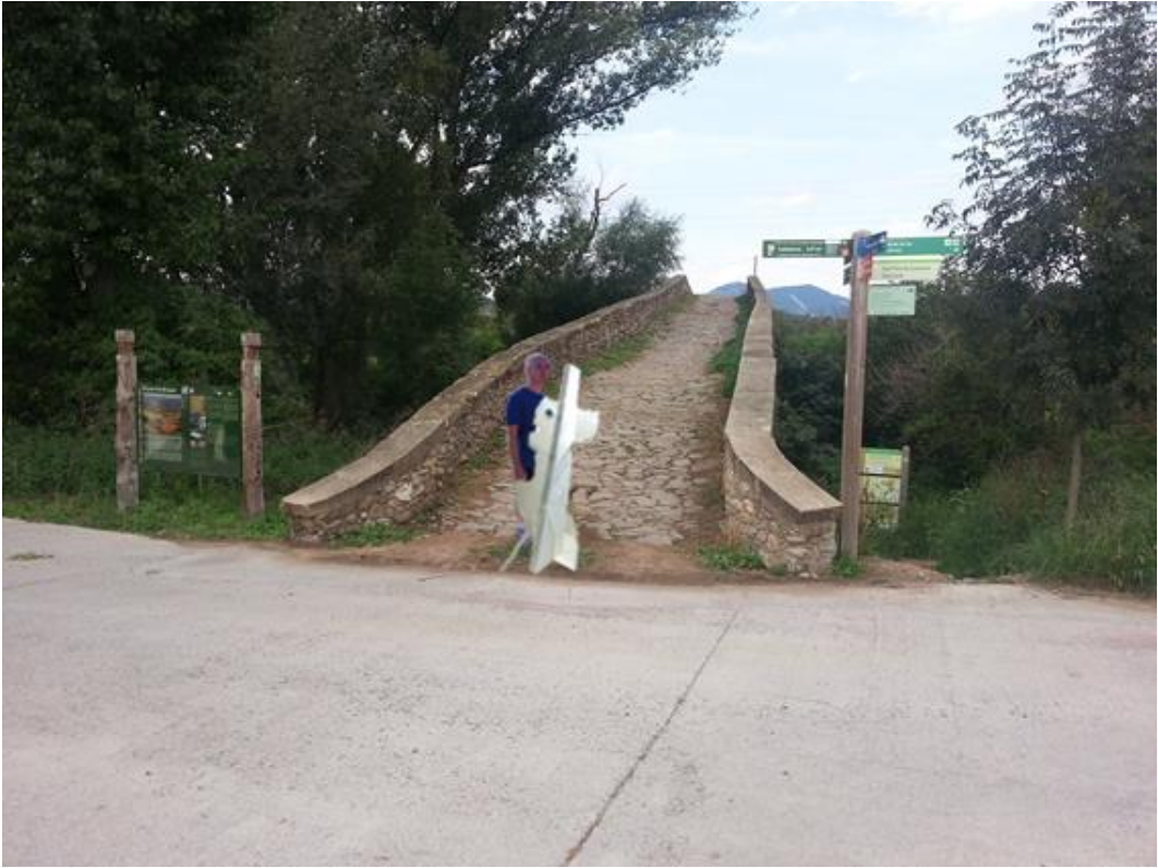
El puente con la escultura de la parte este, retocado con CAD
