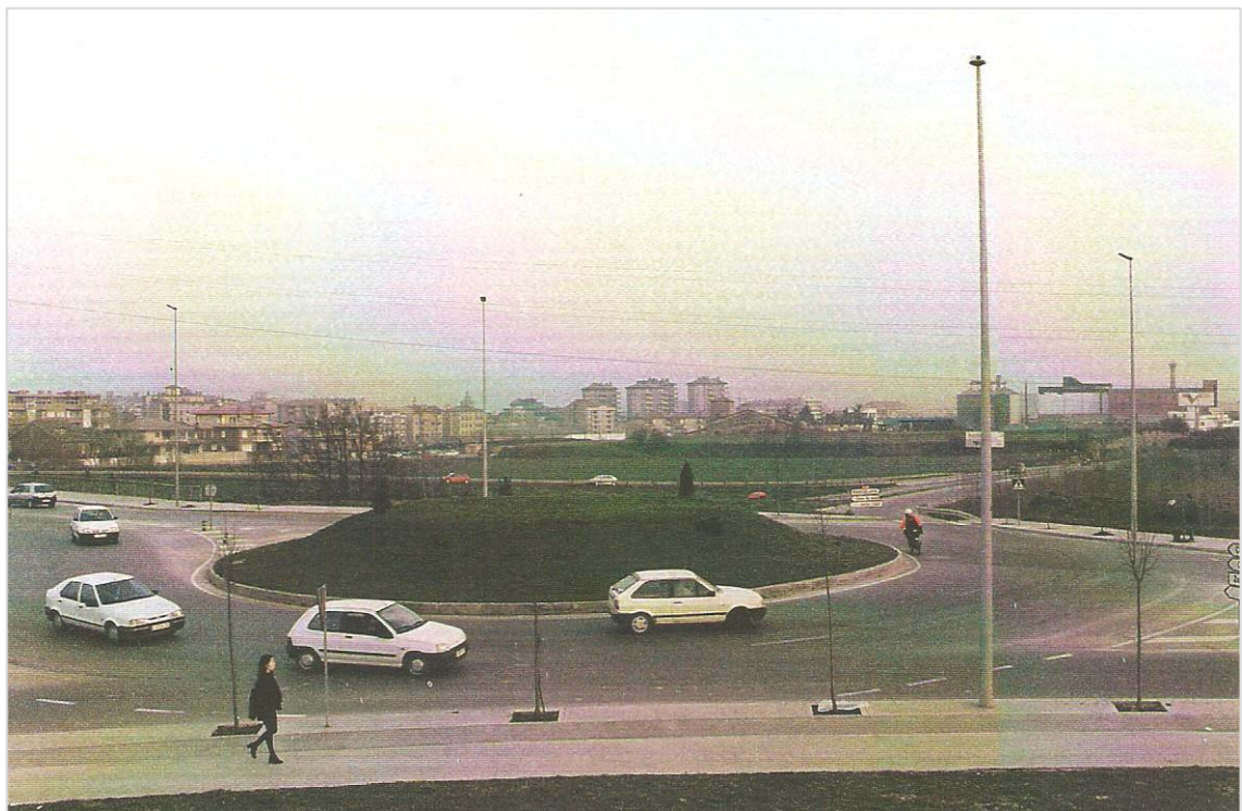
Dos imágenes de la rotonda, estado que presentaba la zona de actuación en el 1997
