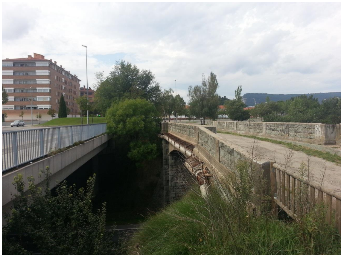
Estado que presenta la zona de actuación en 2015, desde 1997. En la imagen superior charcos fruto de la lluvia, en la imagen inferior el puente para peatones que une las dos rotondas sobre la antigua N-152
