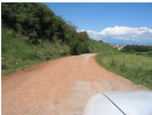
Ejemplo de reutilización de escombros en el espacio público, ladrillos, tejas, para rellenar el Camino de Sant Marc a Calldetenes. Derecha, este material rechazado por la industria, ha sido reutilizado para construir la rotonda de Sentfores, barrio de la ciudad de Vic
