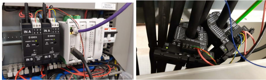
Figura 3.7: Microprocesador y sensores de corriente y tensión
