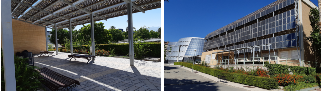
Figura 3.5: Dos vistas del generador fotovoltaico del proyecto UniVer
