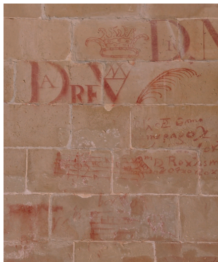
Detalle de la fachada del Seminario Conciliar de San Felipe Neri. Actual sede de Antonio Machado de la Universidad Internacional de Andalucía
