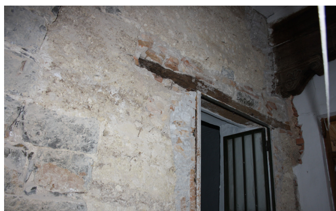
Figura 24. Puerta desde el patio al espacio 13.
