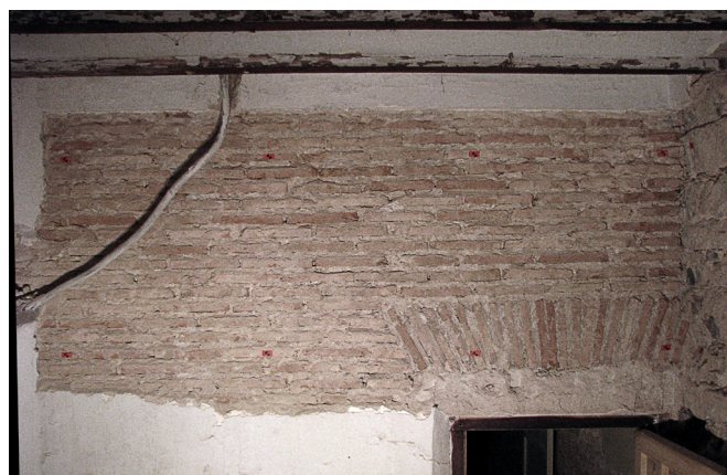
Figura 23. Paramento que divide la sala sur, entre el espacio 12 y 13.
