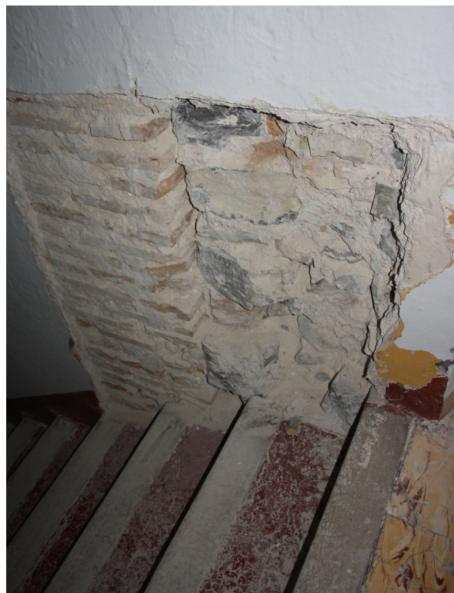
Figura 16. Paramento en la zona superior de la escalera.
