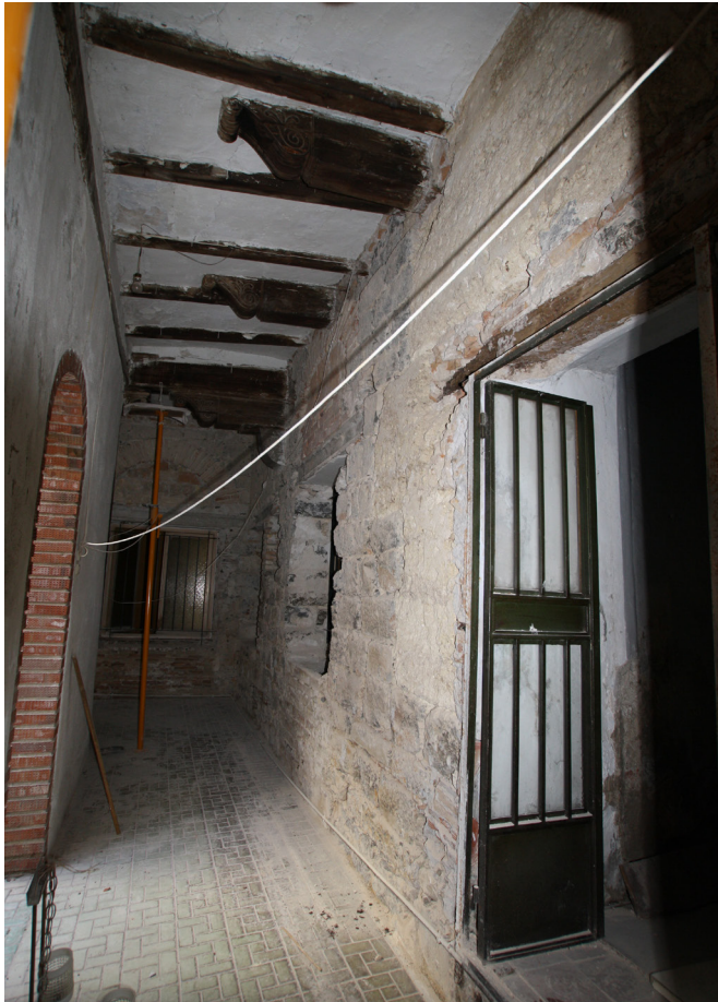
Figura 28. Galería sur. A la izquierda el vano al patio.
