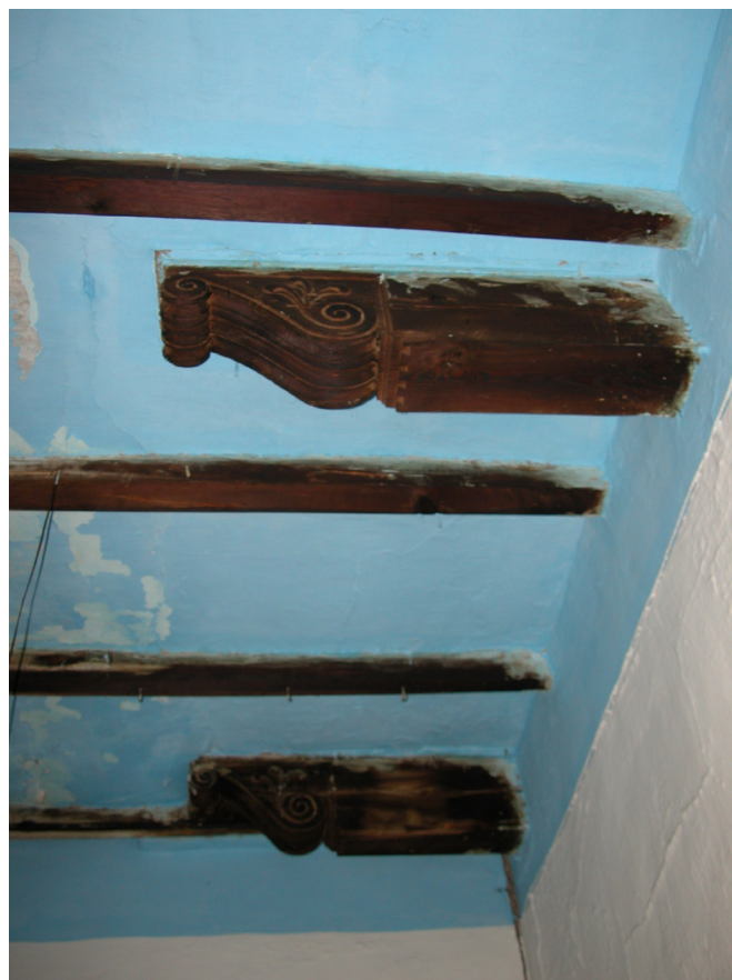
Figura 25. Zapatas en el entrevigado.
