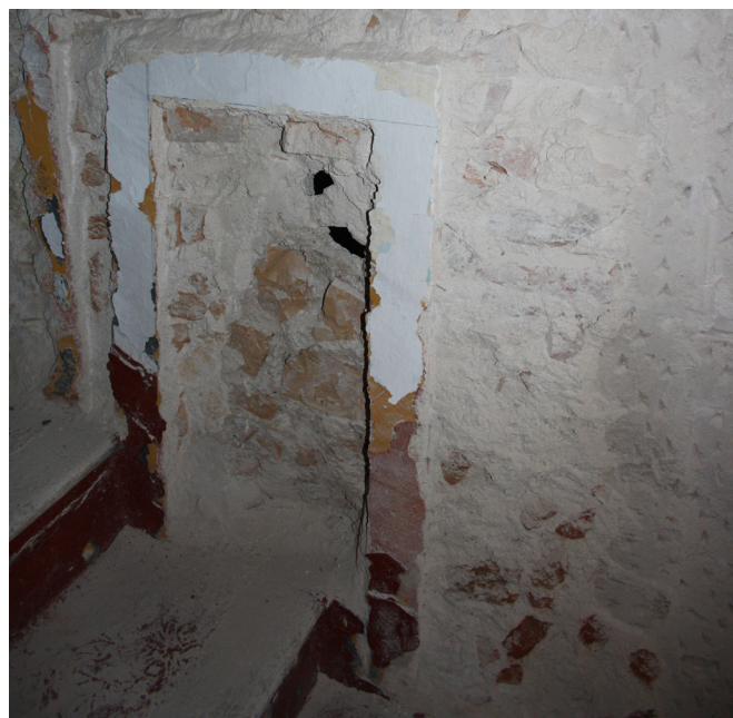
Figura 13. Vano al pie de la escalera.
