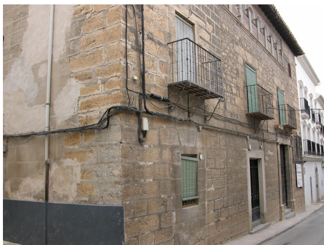
Figura 4. La fachada en 2009, vista desde el sur.
