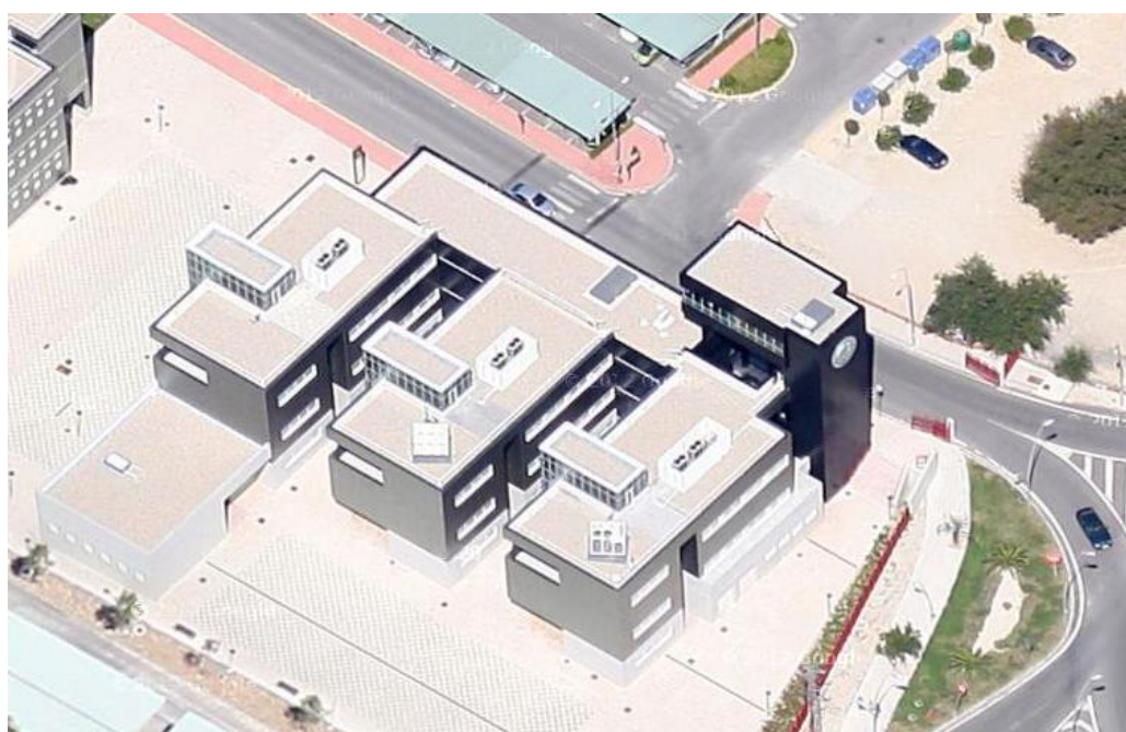
Figura 41. Vista aérea del edificio. Fuente: Proyecto técnico de ejecución.
