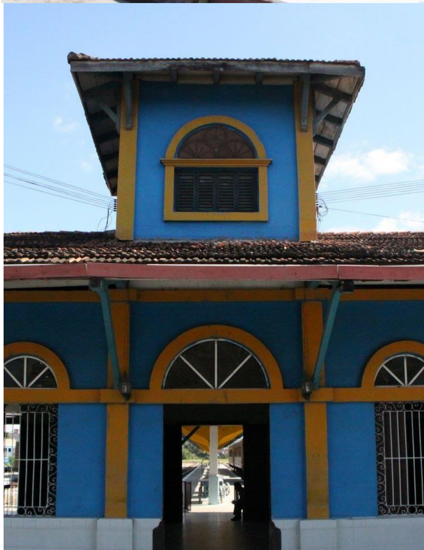
Figuras 63 y 64. Estación de Cienfuegos. Detalles. Fuente: http://mapio.net/s/19461802/ .
