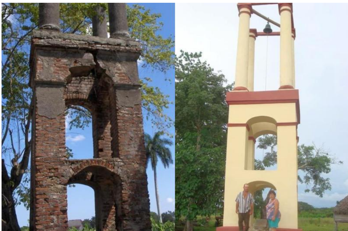
Figura 75. La Torre de Yero antes y después de la intervención. Fuente: Alsina (2021)
