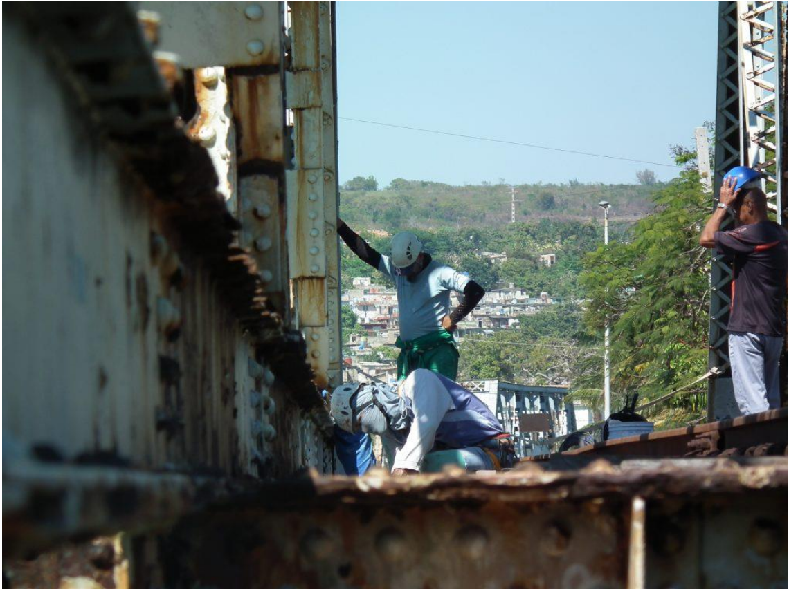
Figura 116. Puente giratorio de Matanzas, estado en marzo de 2023. Fuente: https://www.tvyumuri.cu/matanzas/puente-giratorio-matanzas/
