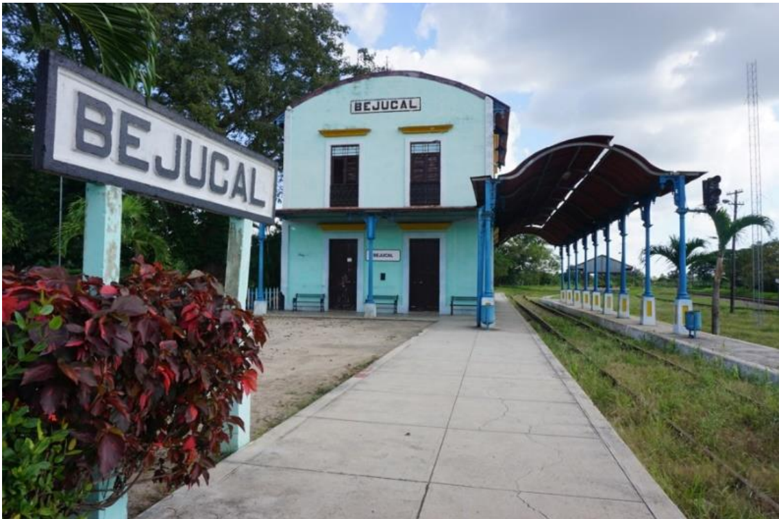
Figuras 42 y 43. Estación de Bejucal. Detalles. Fuente: (Quiroga, 2016a)
