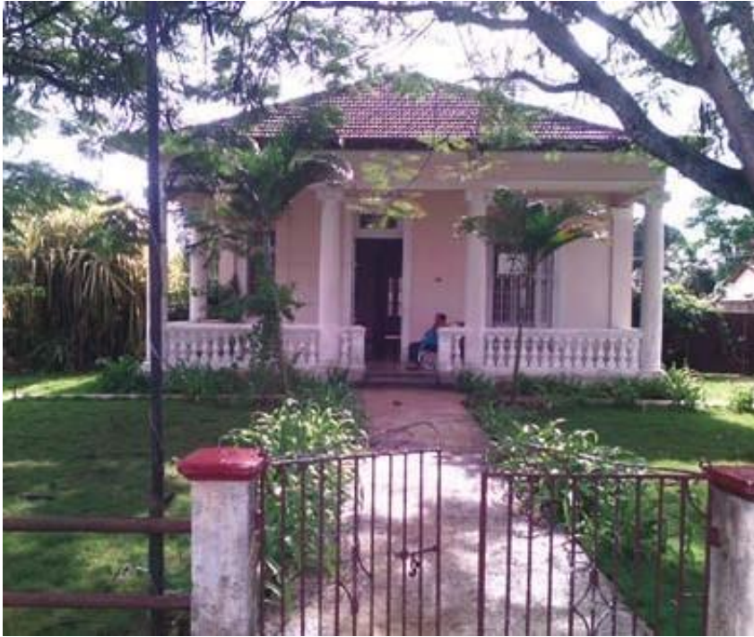
Figura 82. Chalets para directivos del Ferrocarril del Norte de Cuba, Ciego de Ávila. Fuente: Tartarini (2016)
