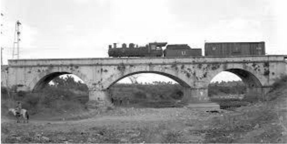
Figuras 60 y 61. Puente sobre el río San Andrés. Fuente: González et al. (2014)
