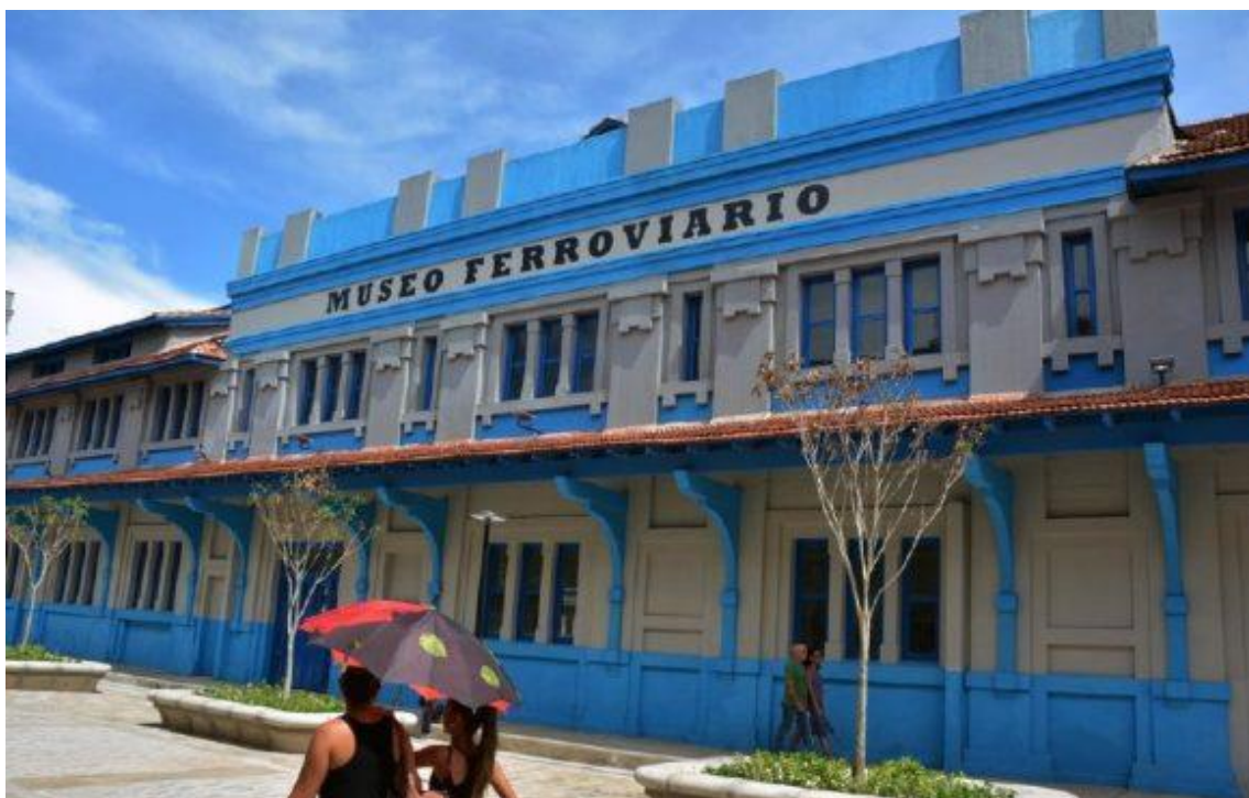
Figura 94. Museo Ferroviario de Camagüey. Fuente: Vega (2021)
