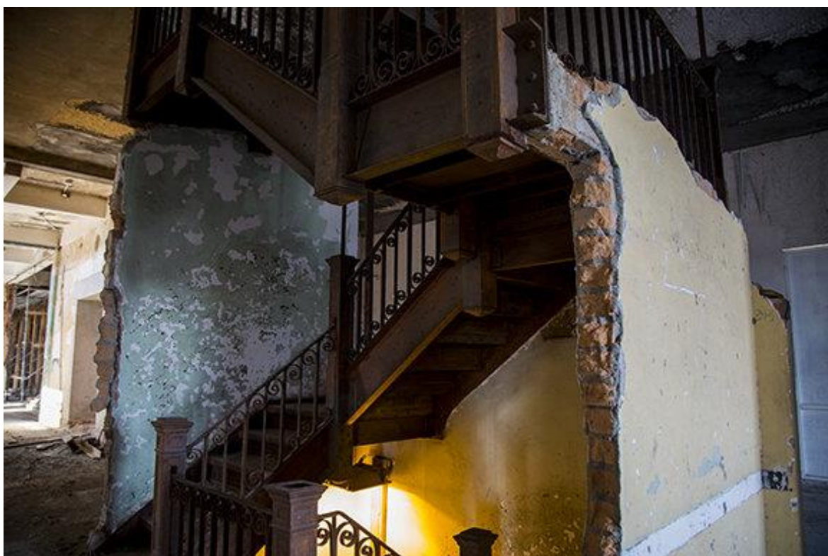
Figura 102. Detalle de la intervención en el interior de la Estación Central de Ferrocarriles de La Habana. Febrero de 2019. Fuente: (Figueredo y Pérez, 2019)
