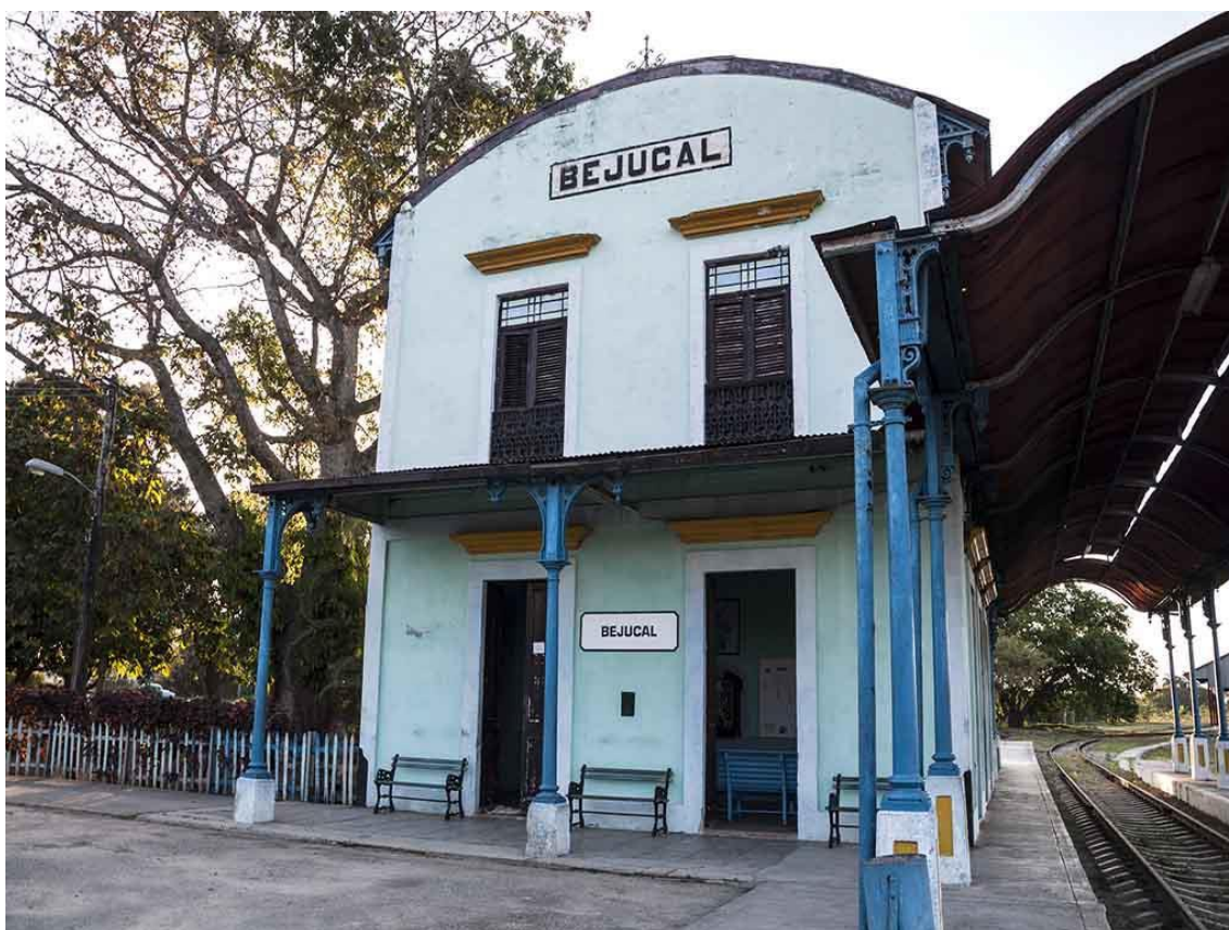
Figura 41. Estación de Bejucal. Fuente: Jiménez (2016)
