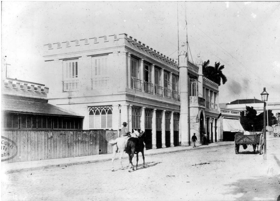
Figura 38. Estación de Villanueva (c. 1900). Fuente: Biblioteca Nacional José Martí , La Habana, Cuba.
