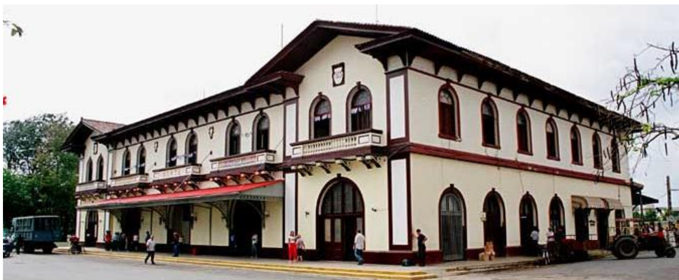
Figura 73. Terminal ferroviaria de Morón, Ciego de Ávila. Fuente:
