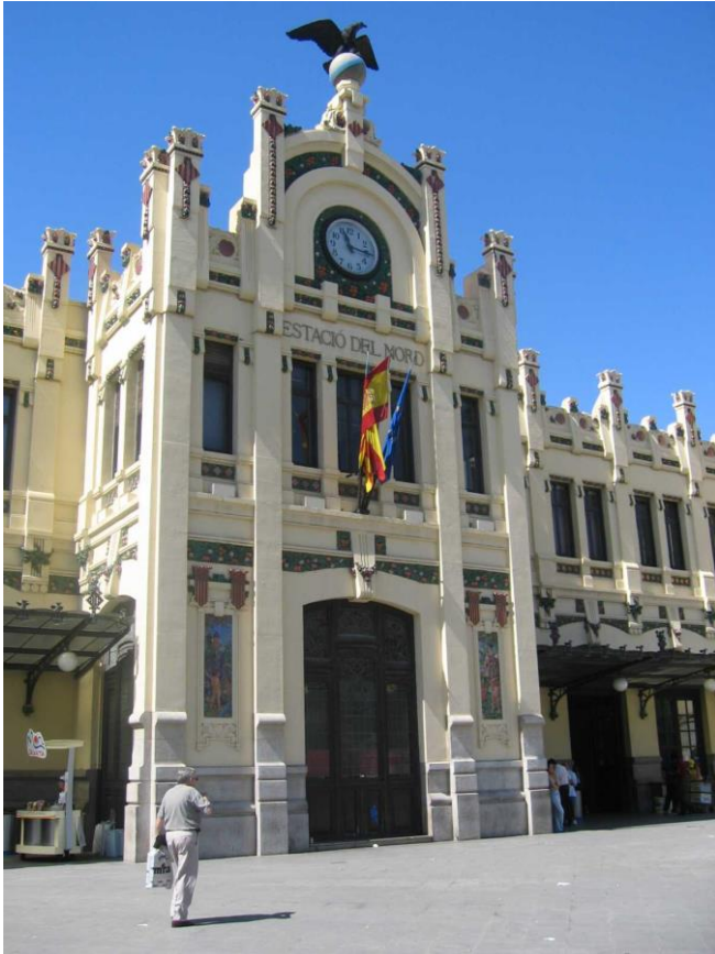
Figura 17. Estación del Norte – Estació del Nord. Fuente: Generalitat Valenciana (2014)
