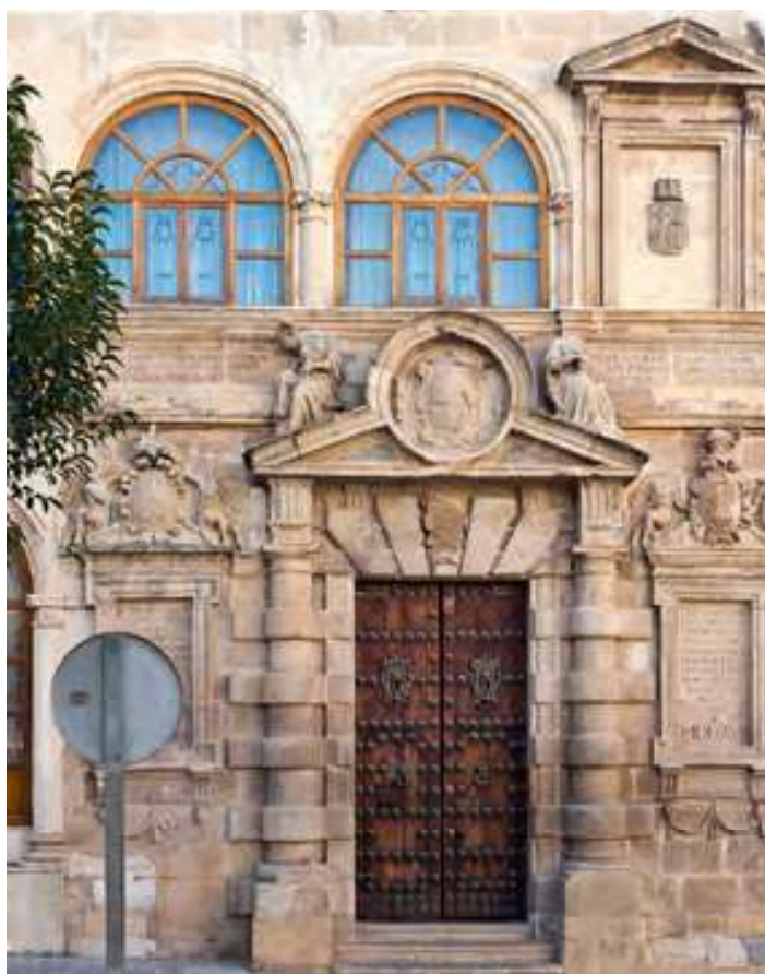
Fig. 2. Antigua cárcel y cabildo, Martos (actual edificio del Ayuntamiento).
