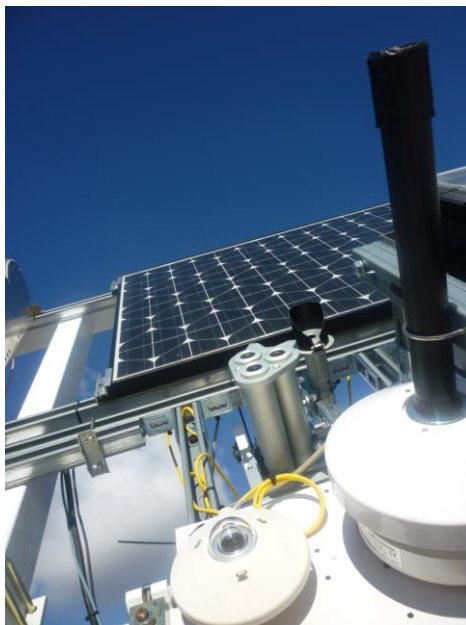
Figura 4.8: Equipos de medida de condiciones atmosféricas colocados en seguidor.
