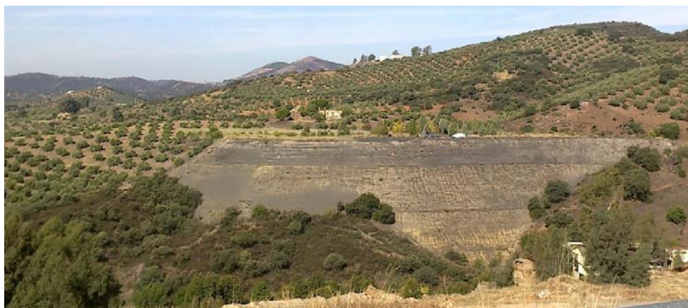
Figura 2.11. Balsa de lodos de La Aquisgrana.
