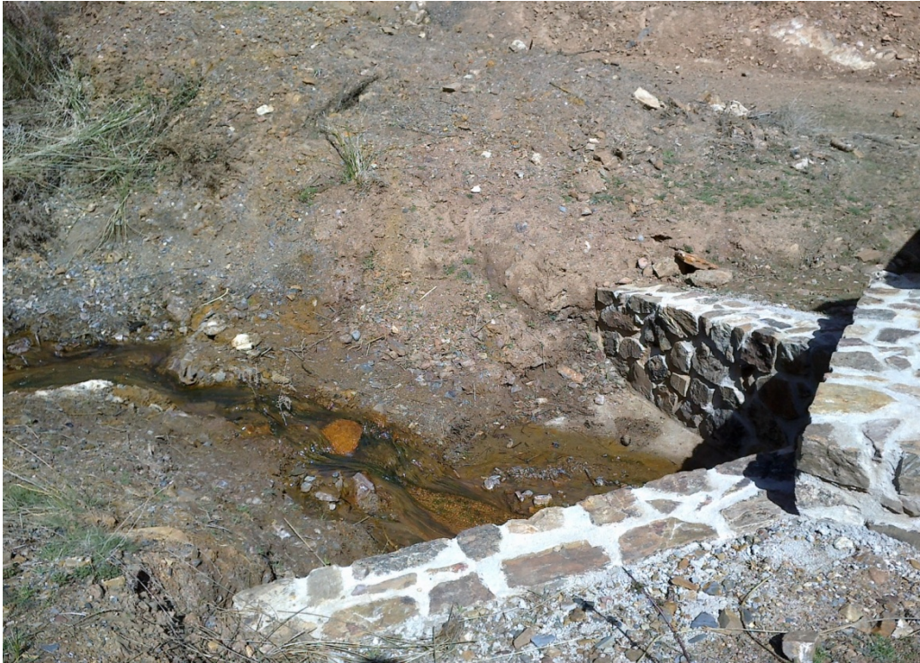
Figura 4.7. Arroyo del Pelaguindas (GM-3) aguas abajo de la salida del socavón.
