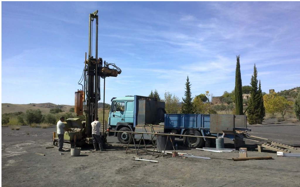
Figura 3.3. Perforación de un sondeo en la balsa de lodos de La Aquisgrana.
