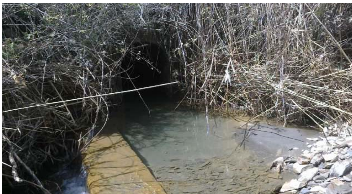
Figura 4.32. Salida del arroyo del Boticario bajo la balsa de lodos de La Aquisgrana.
