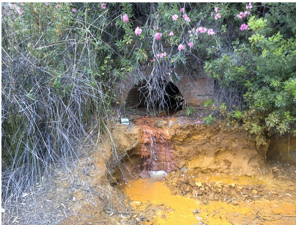
Figura 4.10. Socavón de Los Curas (GM-5) con los característicos colores rojizo-anaranjados pertenecientes a los oxihidróxidos de Fe.
