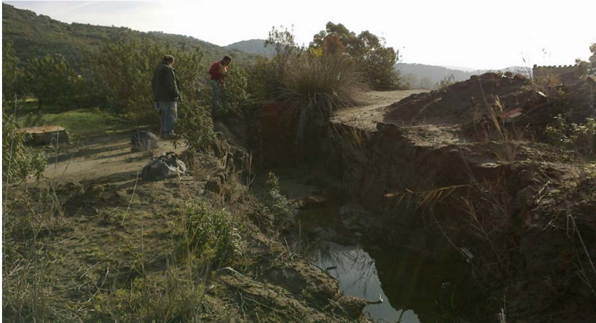
Figura 6.9. Chimenea de drenaje de La Manzana.
