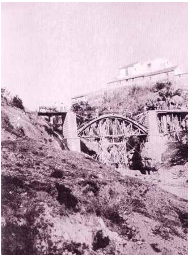
Obras de construcción de un puente del canal construido entre 1923 y 1926 para la nueva traída de las Aguas de Torremolinos.
