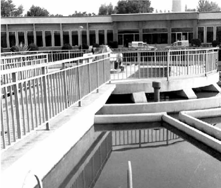
Estación de tratamiento de agua potable Villa Azul de Córdoba, a principios de los 80.
