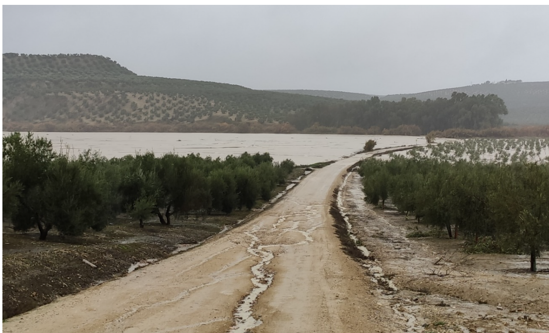
Figura 45. Camino rural no asfaltado que actúa como canal secundario durante los eventos extremos, provocando su rápido deterioro.
