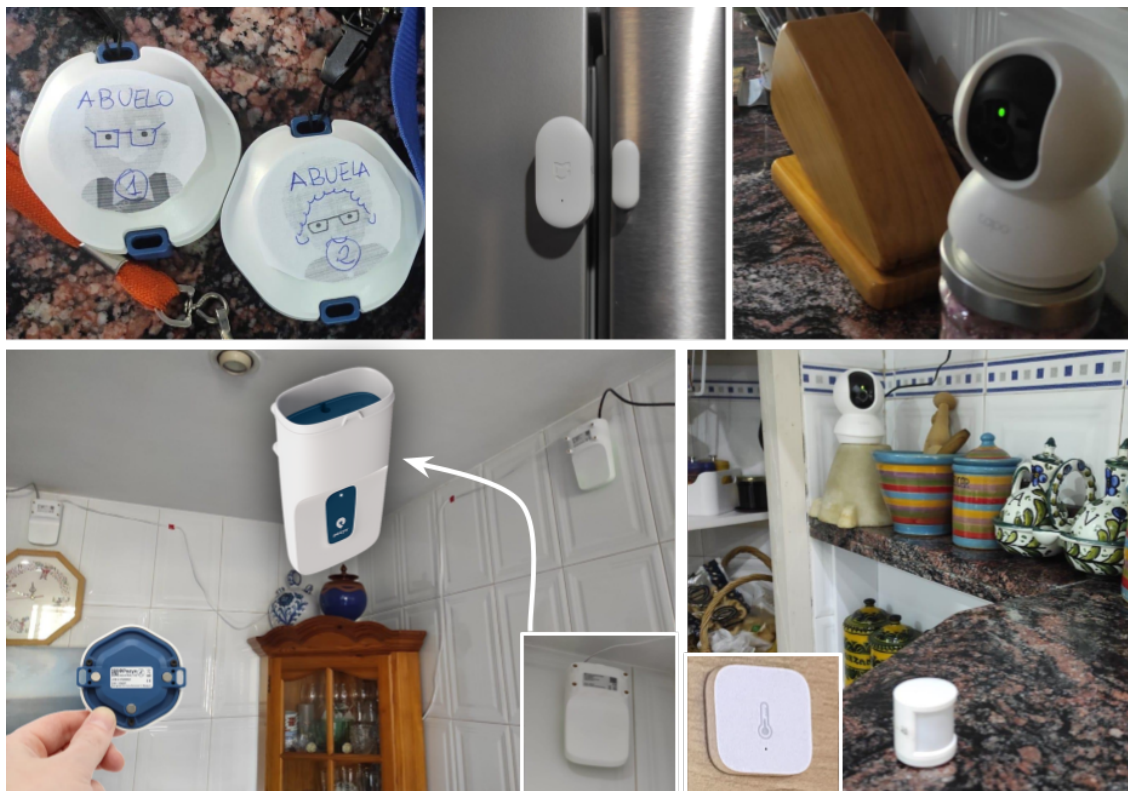
Figura 5.3: Implementación en una cocina que incluye cámaras, sensores ambientales y UWB.
