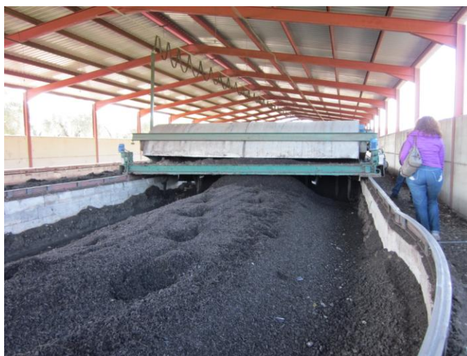
Fig.II.15. Sistema de compostaje semi-cerrado
