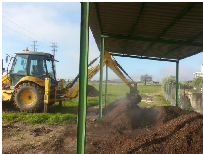
Fig. IV.4. Detalle del volteo de las pilas de compost
