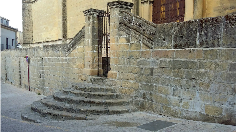
Fig. 13. Gradas de acceso a la portada lateral de la Capilla de S. Juan Evangelista (foto, P. Galera Andreu)
