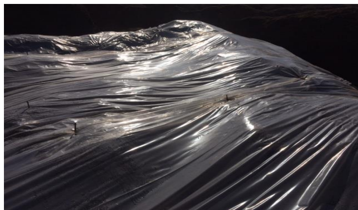
Imagen 49.- Parte superior del acopio tapado con el plástico. [Fuente: Elaboración Propia]
