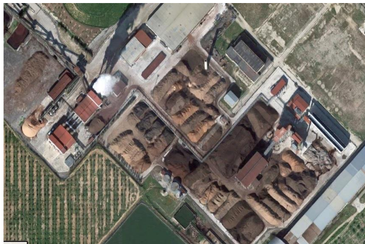
Imagen 28.- Vista aérea de la planta de biomasa de Valoriza Energía en la Estación de Linares Baeza. [Fuente: Elaboración Propia ]
