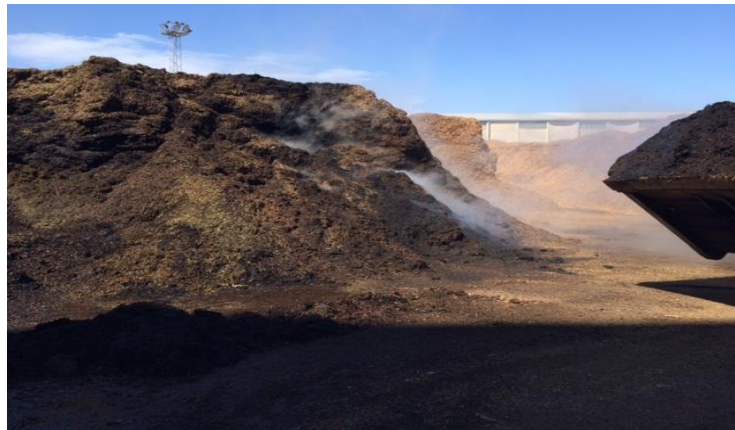
Imagen 50.- Trabajos de saneamiento del acopio. [Fuente: Elaboración Propia]
