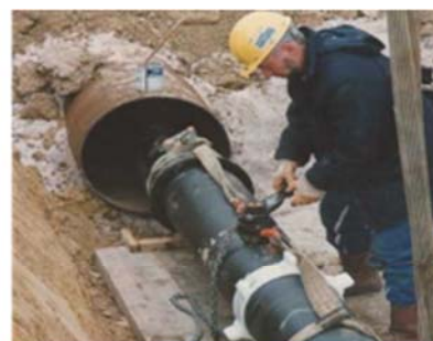
INSTALACIÓN SIN ZANJA
