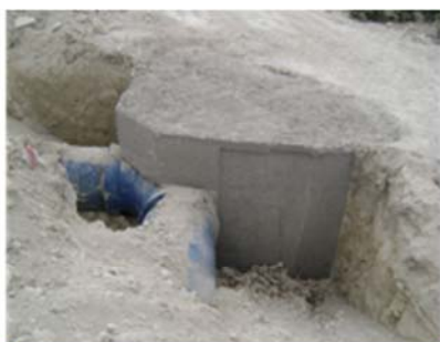
ELIMINACIÓN MACIZOS DE ANCLAJE
