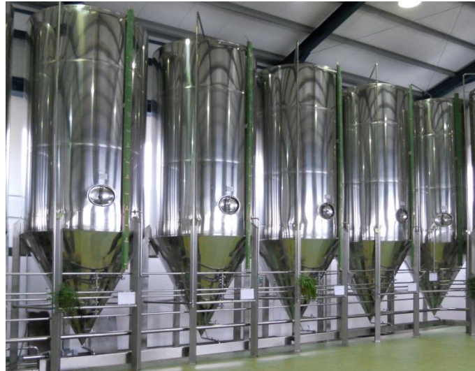
Figura 2.28. Decantadores de fondo cónico
