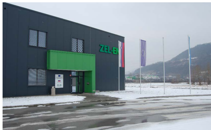
Fig. 107 Vista exterior del centro de investigación ZEL-EN (Krsko-Eslovenia), antes de la realización de las pruebas en la maqueta grande de la turbina S-VAWT 137
