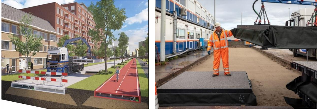
“Plastic roads” de VolkerWessels. A la derecha, detalle de la colocación de los módulos de carretera de plásticos reciclados. Fuente: https://www.volkerwessels.com/en/projects/plasticroad
