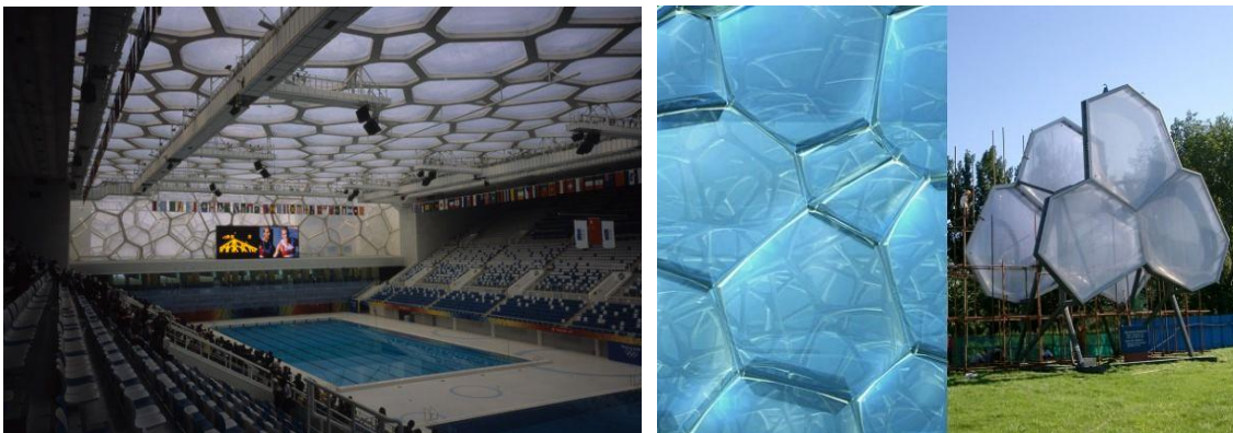
Centro acuático de Pekín "WaterCube". A la derecha, detalle de las placas de EFTE utilizadas en su construcción.
