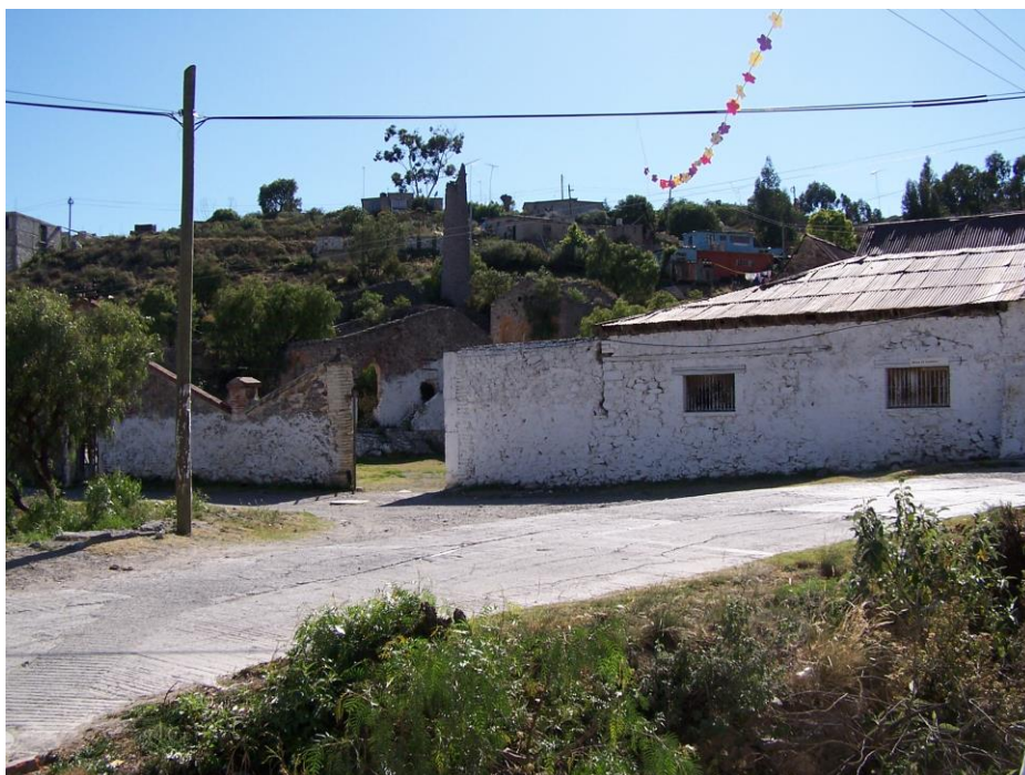
Instalaciones de la mina Camelia, en torno a la que se formó el Barrio La Camelia.
