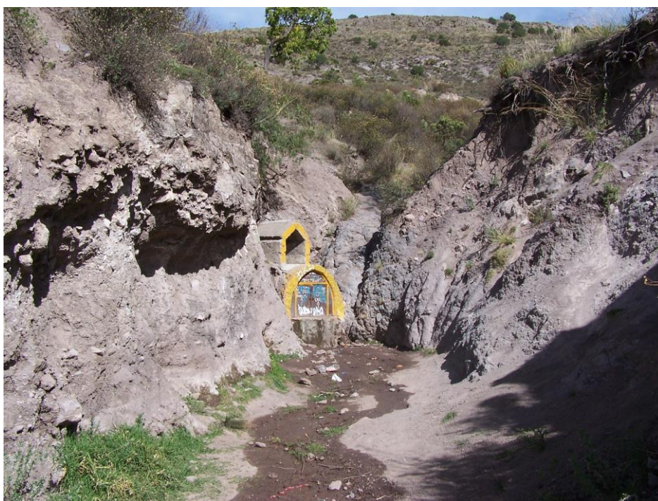
Construcción que protege a un manatíal, ubicado en una de las cañadas del Barrio La Camelia.
