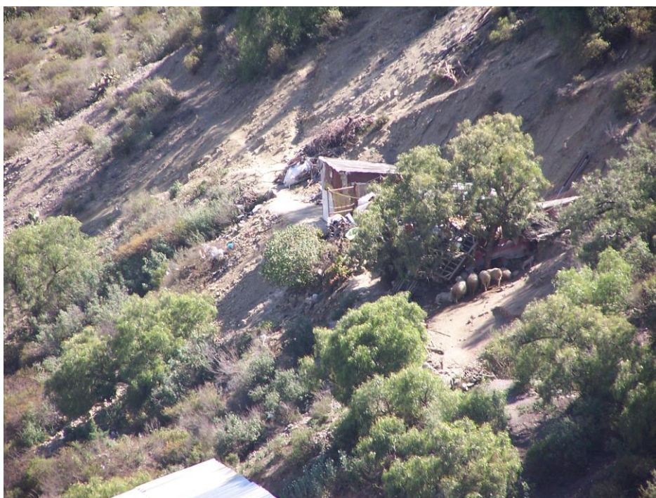
Ejemplo de vivienda sin ningún tipo de servicio, ubicada en una zona de riesgo, por el deslave del terreno y el hundimiento de los antiguos túneles de las minas. Se observa además, la crianza de borregos, que constituye el patrimonio familiar.
