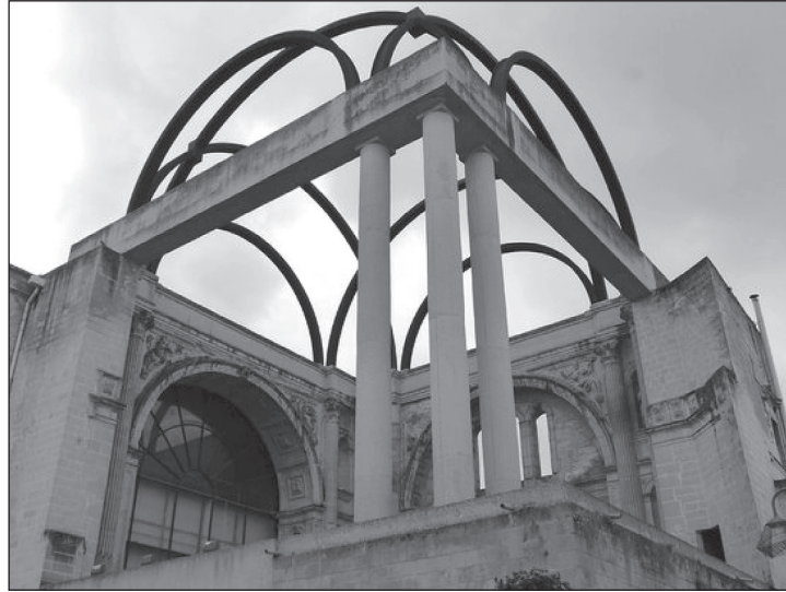
Reconstrucción de la Capilla Mayor (1986)
