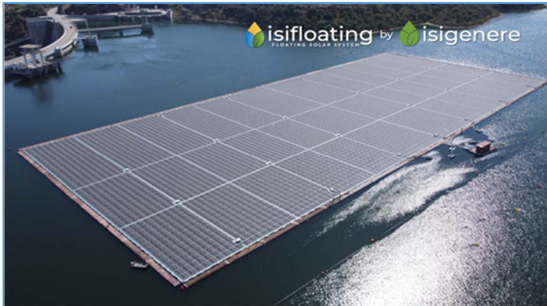
Figura 6. Ejemplo de instalación solar flotante en embalse.
