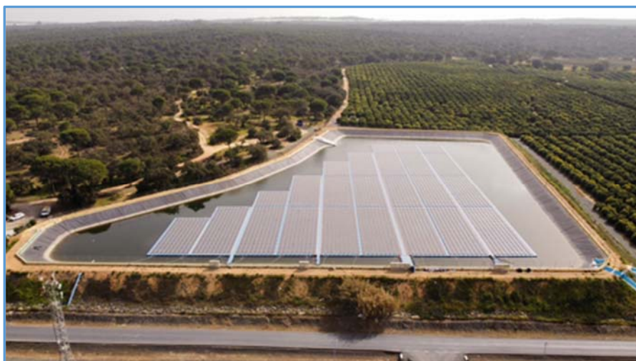
Figura 3. Ejemplo de solar flotante en Balsa de Riego de una comunidad de regantes.
