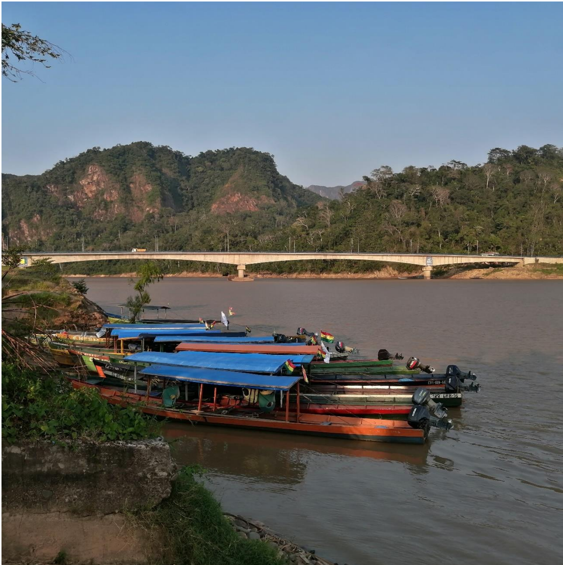
Foto 6: Puente fronterizo entre los departamentos de Beni a la izquierda y el Departamento de La Paz a la derecha, el límite natural es el río Beni
