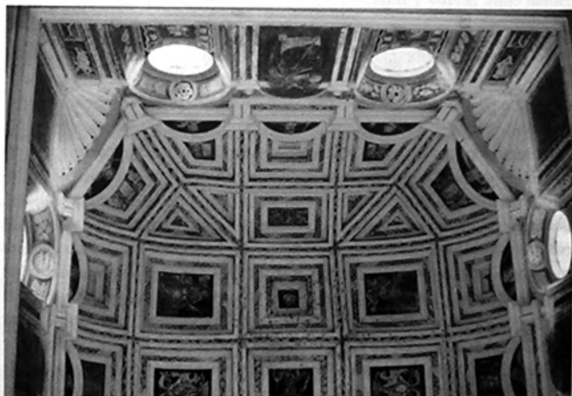
Hospital de Santiago (Detalle escalera).
