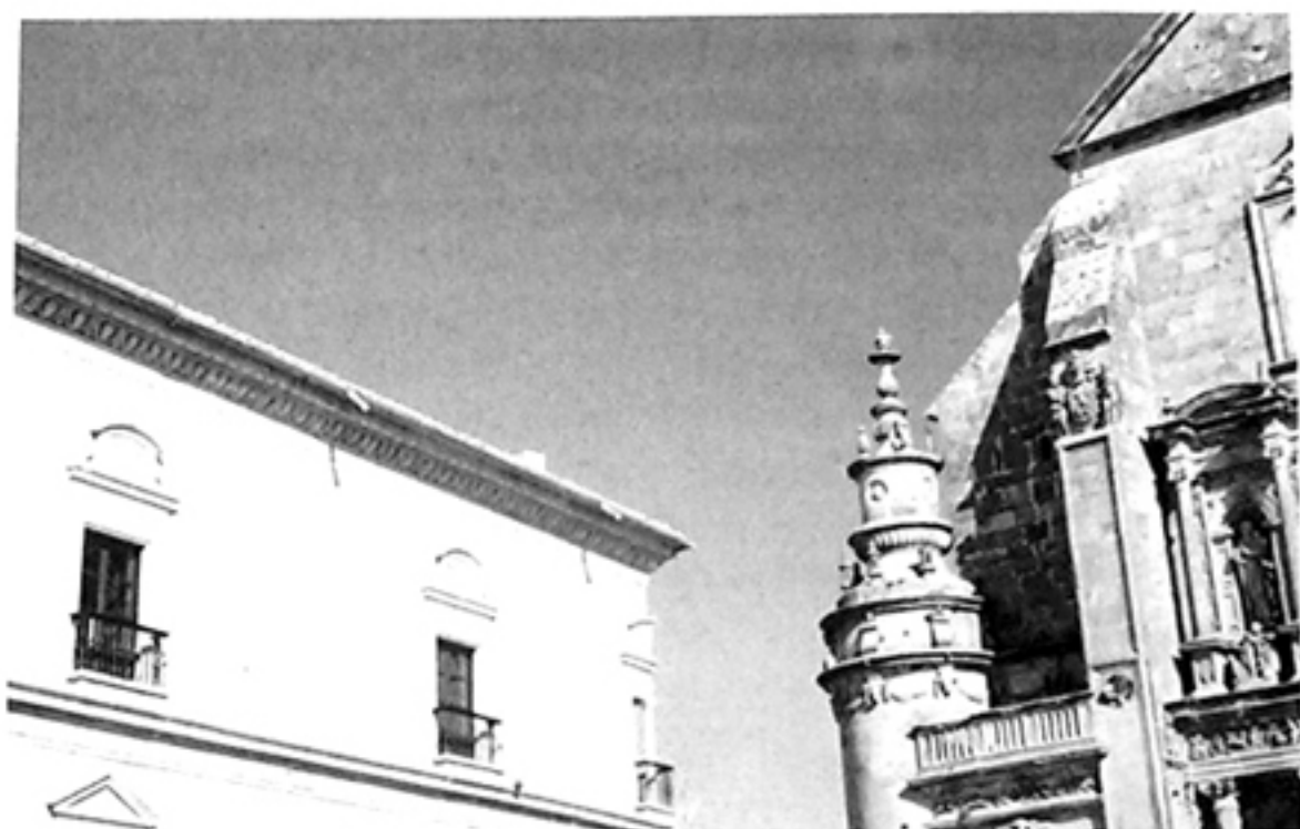
Salvador de Úbeda. Encuentro en esquina del palacio Deán Ortega y la iglesia de El Salvador.
