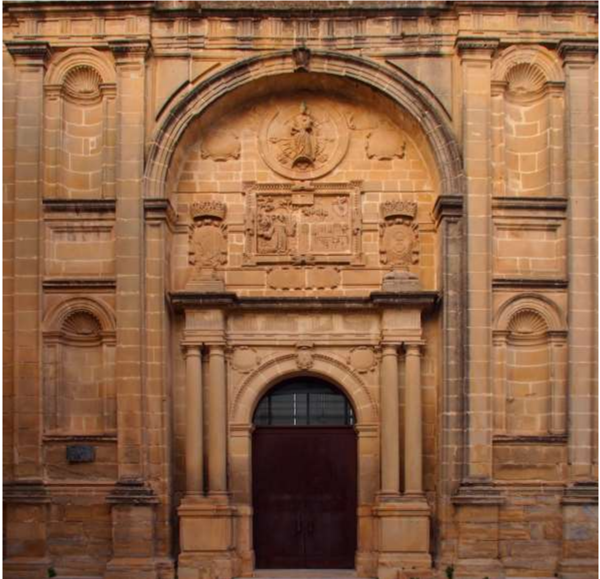
Baeza, fachada de la iglesia del convento de San Francisco, ca. 1627.
