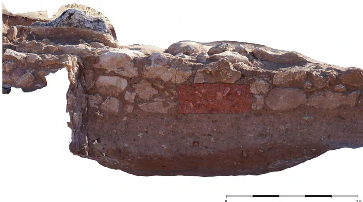
FIG. 146 Detalle en muro M303.
