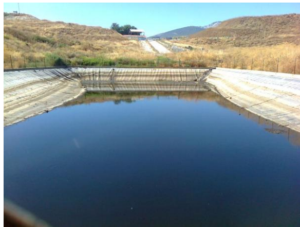
Figura 27. Balsa de lixiviados "nueva".
