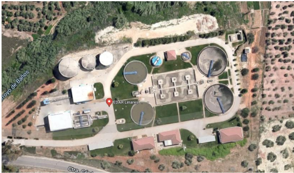
Figura 1 - Depuradora de Linares
