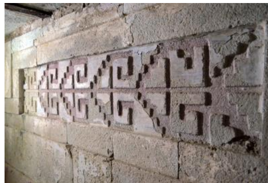
Imagen 143.- Muro lateral 2 parte de la cámara 1. Fotografía Jorge Porras A.
