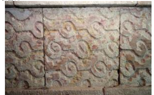
Imagen 139.- Muro lateral 1 parte de la antecámara de acceso. Fotografía Jorge Porras A.
