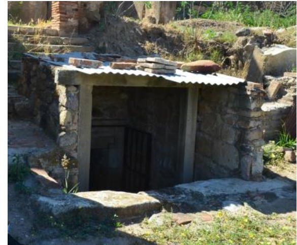
Imagen 240.- Situación actual de la cubierta de acceso a la tumba.
