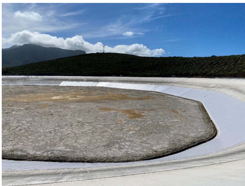
Figura 2. La balsa de Montaña de Taco durante los trabajos de re-impermeabilización
