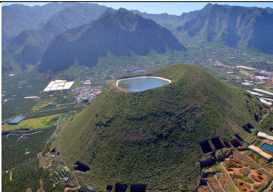
Figura 1. Vista panorámica de la balsa de Montaña de Taco, construida sobre un cono volcánico
