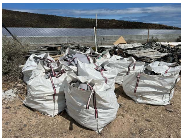
Figura 3. Sacas para la recogida de mermas generadas durante la instalación de la lámina
