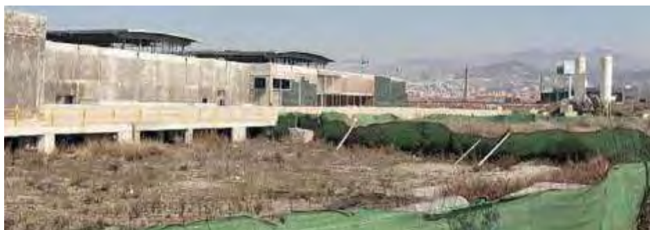
FIGURA 3: Mil metros a medio construir del Centro Comercial Parque Nevada, en el Camino Viejo de Alhendín (Granada). Fuente: andalucianoticias.es 1
