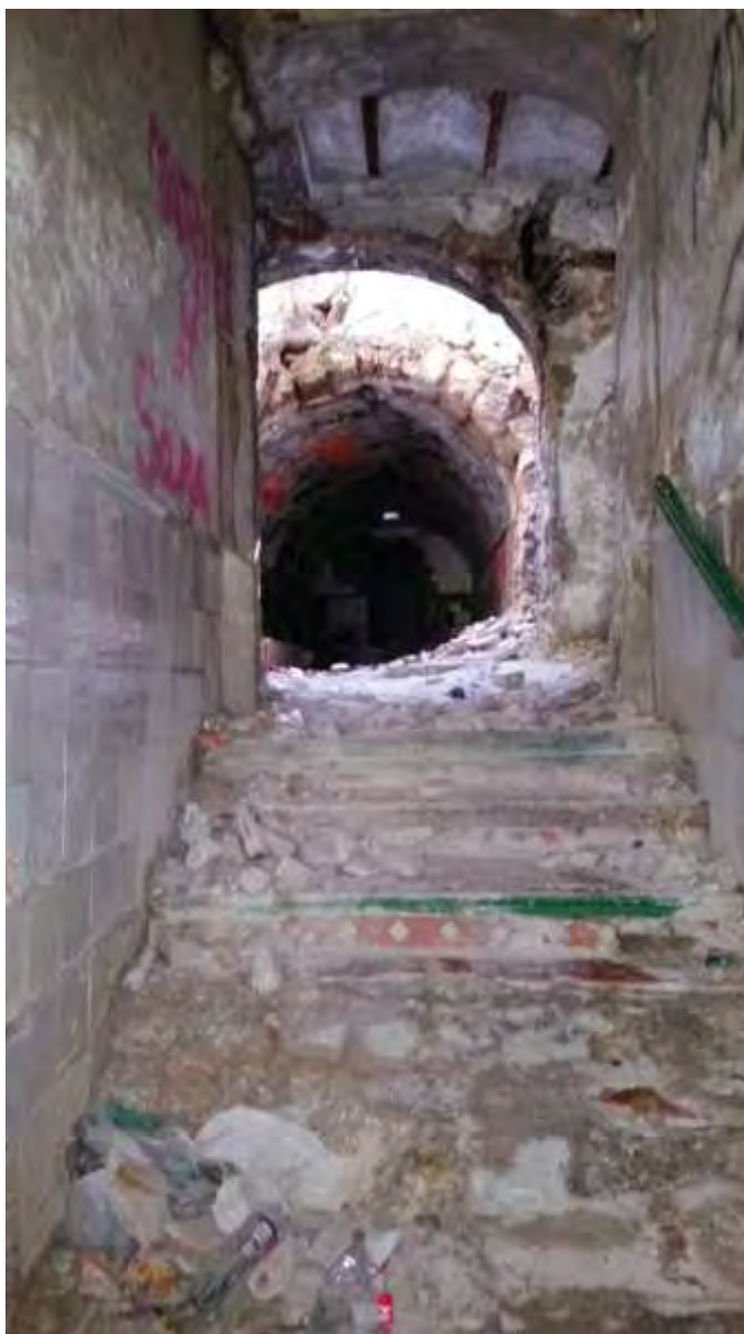
Figura 33: Edificio Balneario. Escalera de acceso a Fonda, 2014.
