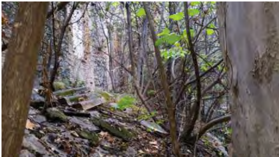
Figura 27: Edificio Balneario. Bóvedas sobre piscinas, 2014
