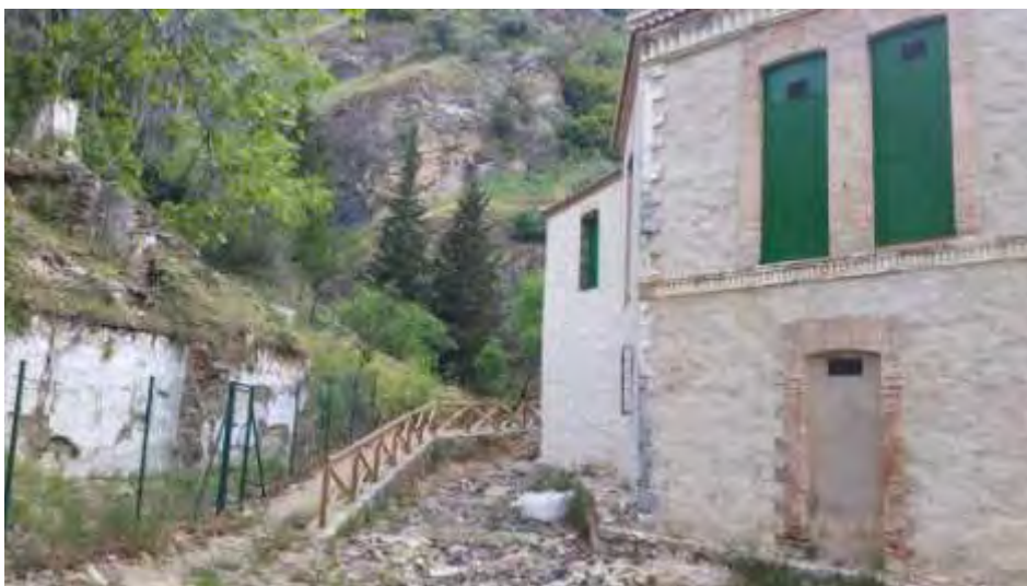
Figura 38: Fachada paralela al río, extremo sur, 2017.
