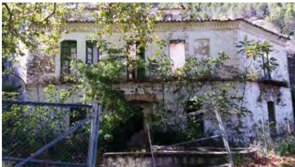
Figura 19: Edificio Balneario. Fachada Este, 2014
