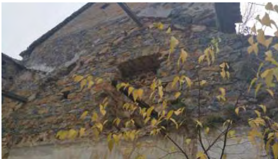
Figura 25: Edificio Balneario. Cubierta del vestíbulo de la Fonda, 2014 Fuente: Propia.
