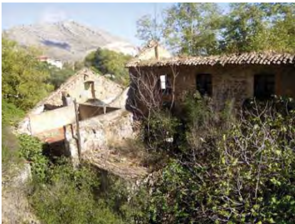
Figura 18: Edificio Balneario. Fachada oeste y cubiertas, 2014
