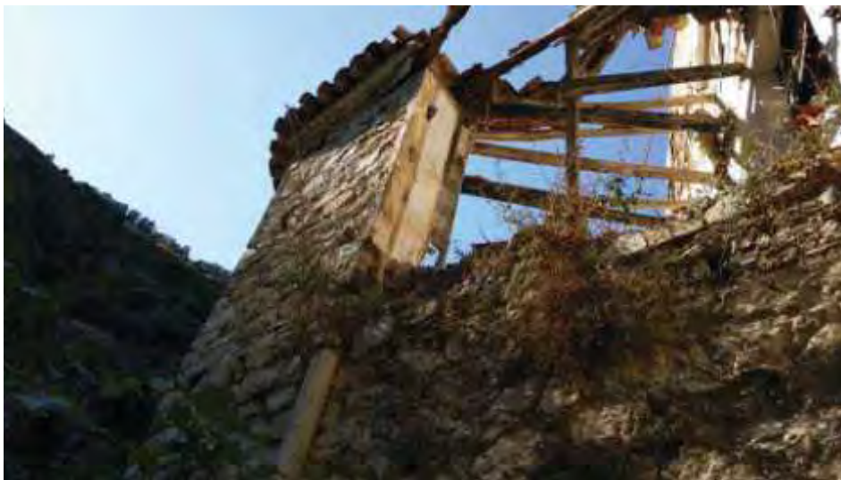
Figura 23: Edificio Balneario. Encuentro en chaflán, 2014
