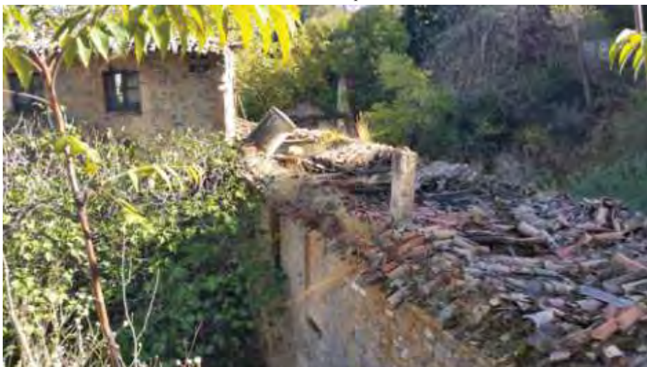
Figura 24: Edificio Balneario. Módulo trasero o cuadras, 2014
