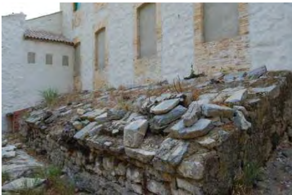
Figura 41: Vista de la bóveda desde el patio interior, 2017.
