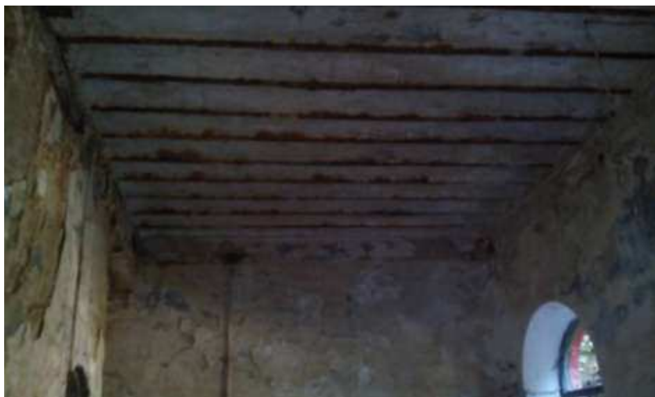
Figura 26: Edificio Balneario. Forjado metálico de la galería de baños individuales, 2014.
