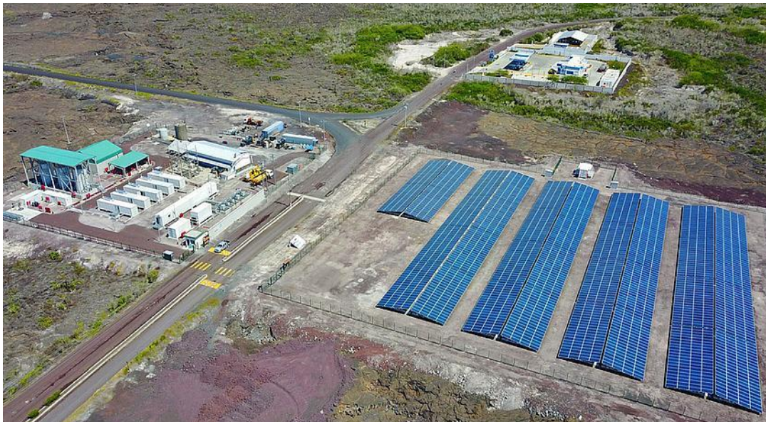
Fig. 5.20 - Proyecto planta de energía híbrida Isla Isabela, Galápagos.
