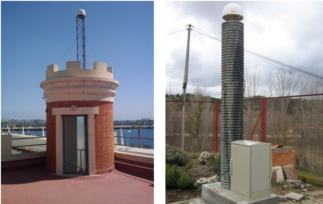
Figura 7.2: Ejemplo de monumentación de estación permanente mediante mástil de acero (ALAC) y pilar hormigonado (TERU)
