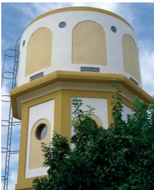
Imagen 7. Depósito de agua en localidad sevillana, Andalucía (Fotografía: J. Raúl Navarro García).
